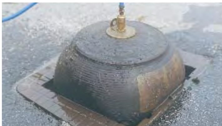
Tätning av avloppsbrunn med tätningskudde.
