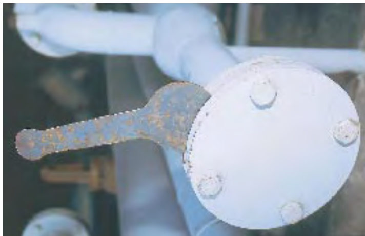
Tätning av fläns med flänsspatel.
