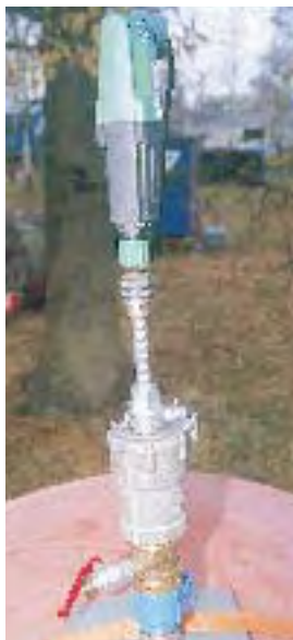
Håltagning i tank.
