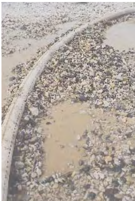
Vattenfylld grovslang som förankrats med grus.
