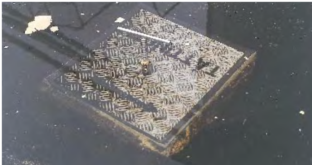
Täckning och tätning av avloppsbrunn.
