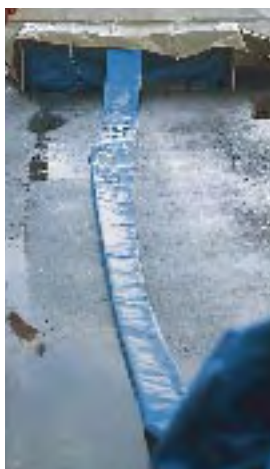
Återkondensering med tratt och uppsamling i en övertäckt bassäng.
