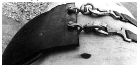
Bild 4.14: Tätningskudde fastgjord med lastspännare och fylld till 150 kPa.
