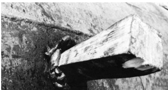
Bild 4.4: Formgummi och träkil
