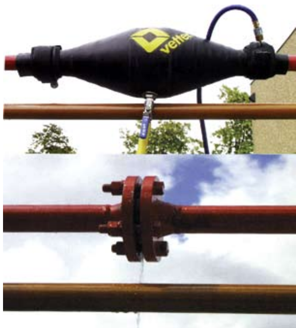
Bild 4.31: Flänsförband med avtappning (Bilder: Vetter GmbH)
