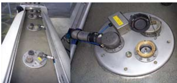
Bild 6.3: Nödtömningsventil (Bilder: Hylander)
